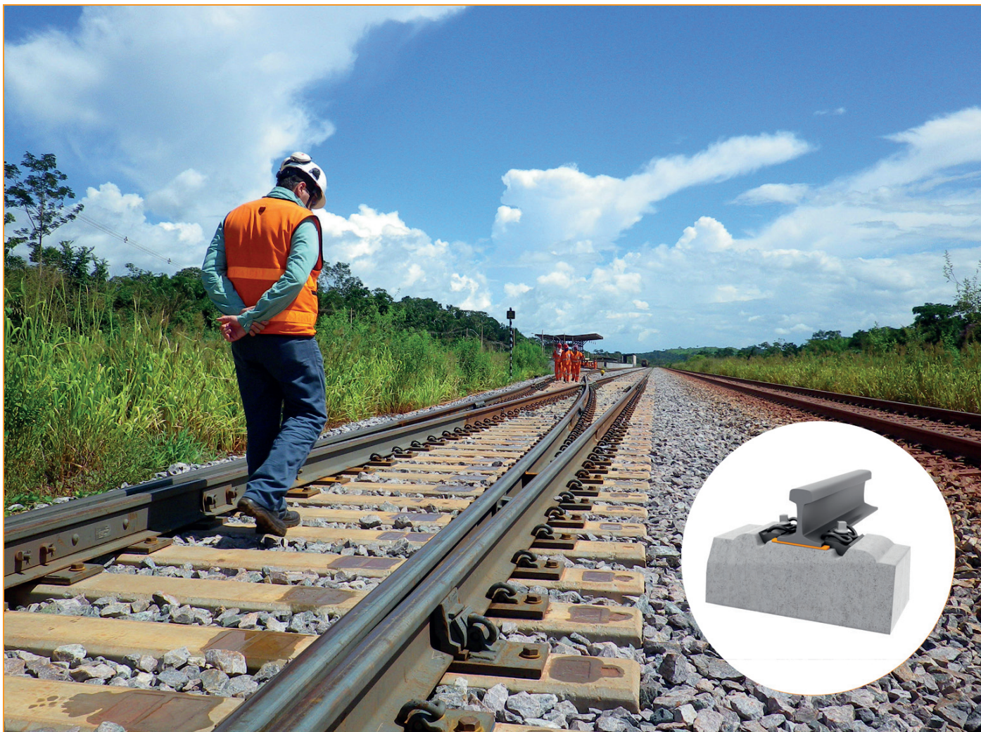
Abb. 12: Getzner Zwischenlagen aus Polyurethan im Eisenbahnoberbau
